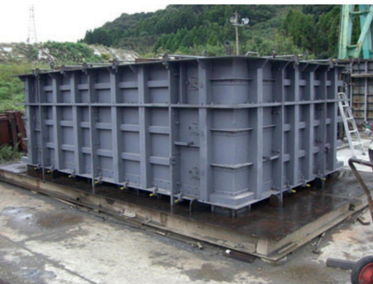
Les figures 1 et 2 montrent le coffrage nécessaire à la fabrication du dalot, avec un poids en béton de 12,3 t.
