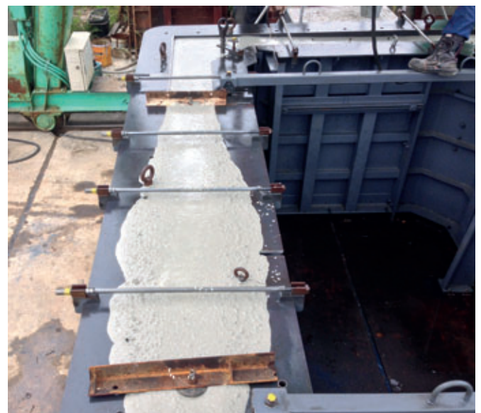
Les figures 1 et 2 montrent le coffrage nécessaire à la fabrication du dalot, avec un poids en béton de 12,3 t.
